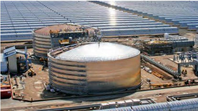
2 serbatoi cilindrici di 14 metri d'altezza e 36 metri di diametro, contenenti 28500 tonnellate di sali fusi.
