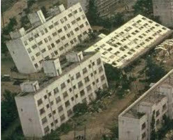
Trasformazione di un materiale granulare da uno stato solido ad uno liquido come conseguenza dell'aumento della pressione neutra dell'acqua nei pori e la riduzione delle tensioni efficaci (Marcuson, 1978)
