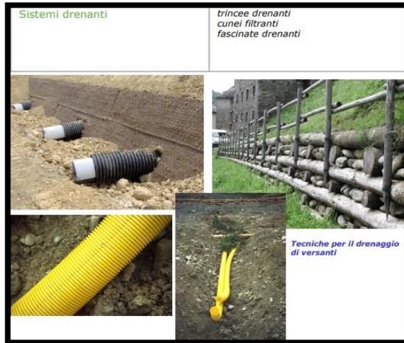
**Tipologia di intervento di sistemazione idraulica: trincea drenante**
