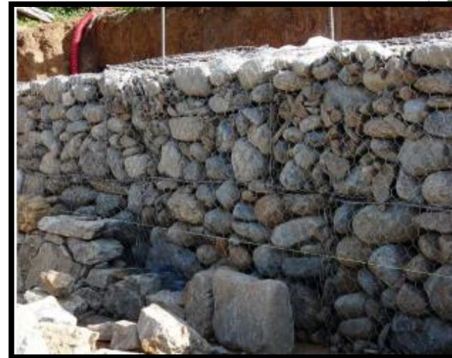
**Tipologia di intervento di sistemazione idraulica: gabbionata**
