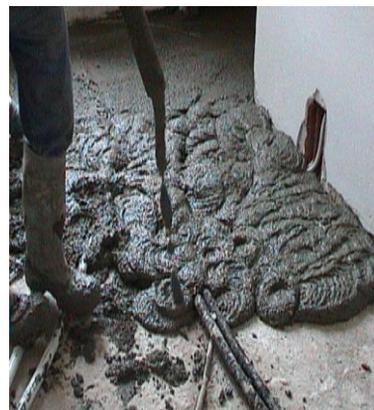
La vermiculite, minerale che rappresenta una variazione morfologica della mica, trova anch'essa grande applicazione negli USA come aggregato leggero per il cls: tale conglomerato presenterà una densità compresa tra i 320-650 Kg /m<sup>3</sup> ed una conducibilità elettrica di 0,014 W / m°C . Presenta una resistenza al fuoco di 1 ora e mezza.
