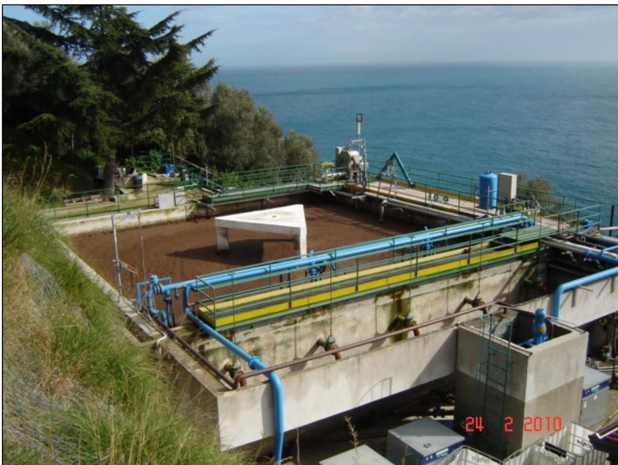
Con tale sistema, la separazione della biomassa avviene mediante un processo fisico di filtrazione invece che per sedimentazione come negli impianti convenzionali a fanghi attivi; il denominatore comune con questi ultimi è dato dal processo di degradazione della sostanza organica e degli altri nutrienti, che sono presenti nel refluo in ingresso all'impianto, che è garantito dalla attività dei microrganismi.
