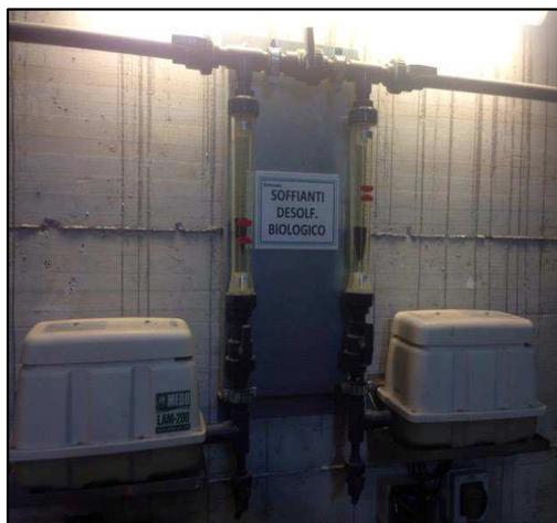
Figura 1 - Soffianti per l'aggiunta di aria.
