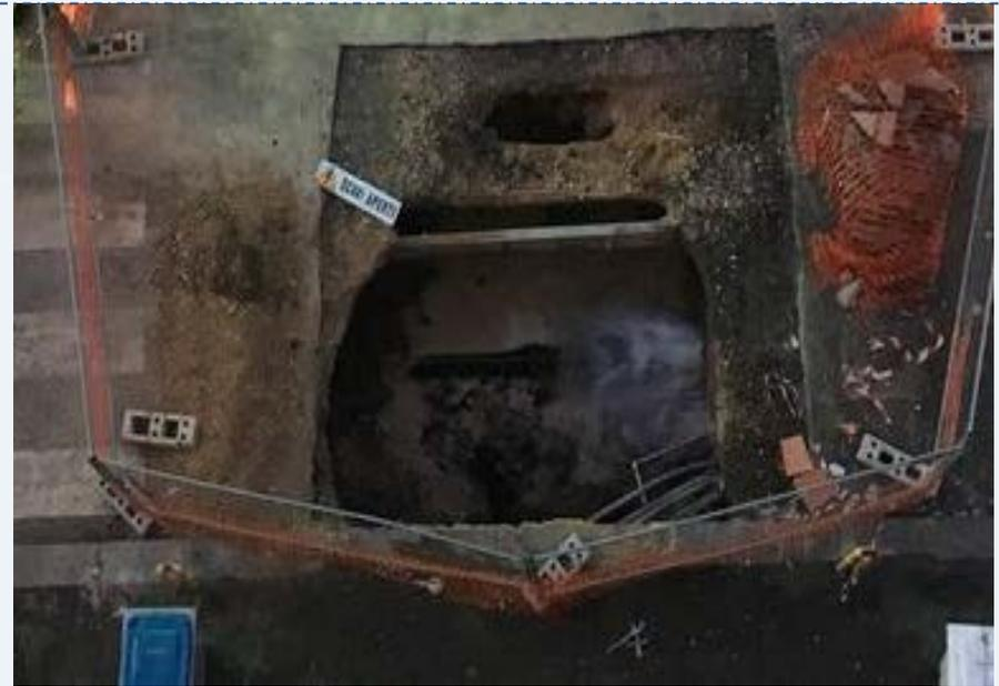
Rilievo del collasso stradale in Via Pigna (NA) in data 10/04/2018, provocato dalla rottura di una condotta idrica
