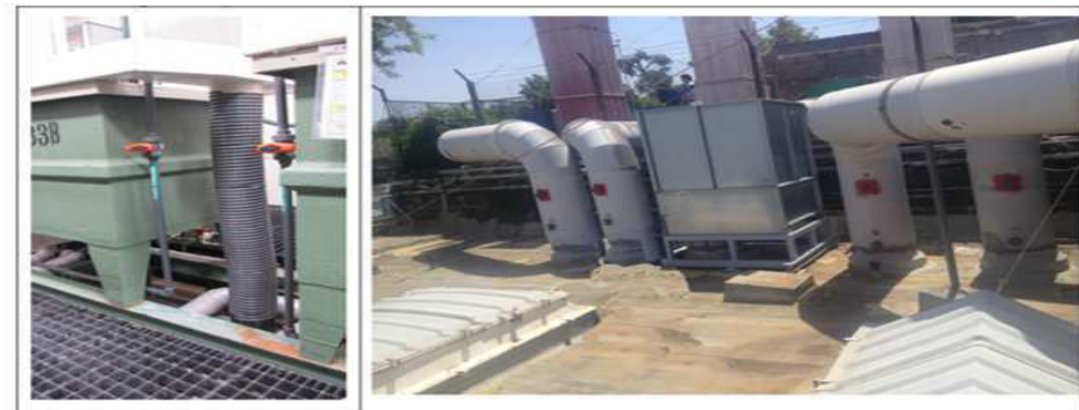
Figura 2: Rilievo delle canalizzazioni instradate sotto pavimento tecnico e dei ventilatori centrifughi in copertura
