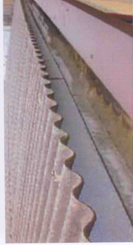
Copertura in eternit in buono stato
