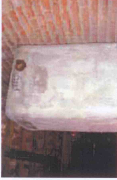
Vasca per l'acqua in cemento amianto
