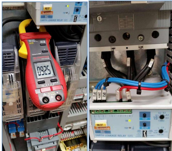
Figura 4 - Pinza amperometrica utilizzata sulla sinistra - Fasi di alimentazione del compressore sulla destra
