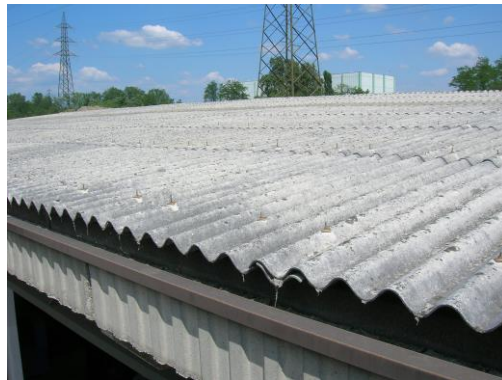
Lastre di copertura
