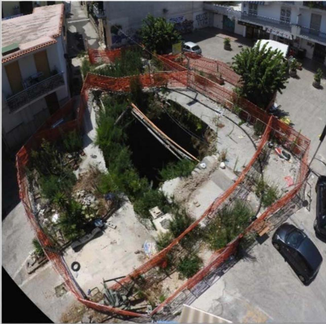
Il 3 agosto 2015 in via De Gasperi si origina una profonda voragine con un diametro di circa 8 metri, provocando la rottura della rete idrica e fognaria.
