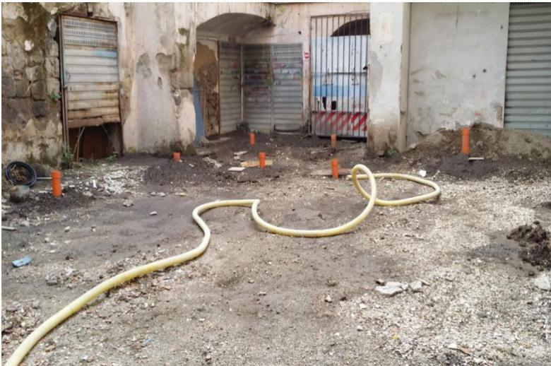
Primo riempimento con materiale arido e secondo riempimento con cemento cellulare.
