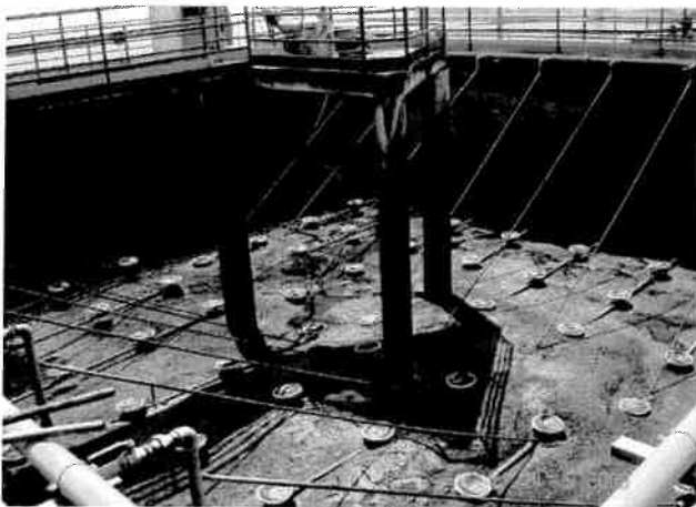
Figura 2 Reattore biologico prima dei lavori di adeguamento
