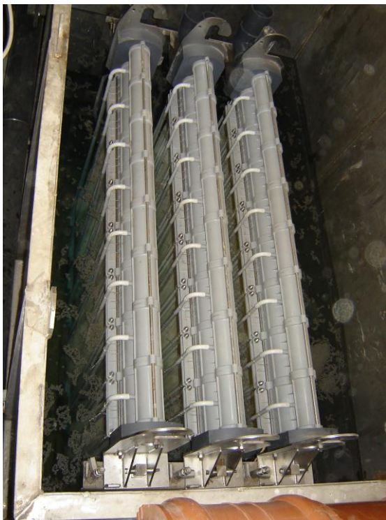
Figura 9 Cella MBR Siemens a fibre cave con tre racks avente ciascuno otto moduli a membrana
