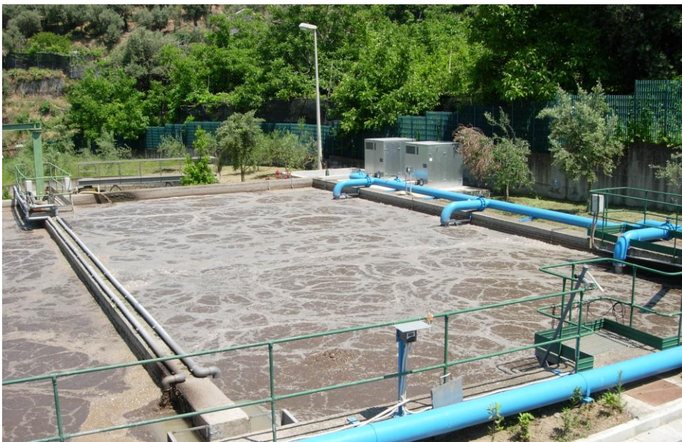
Figura 1 Reattore biologico a fanghi attivi
