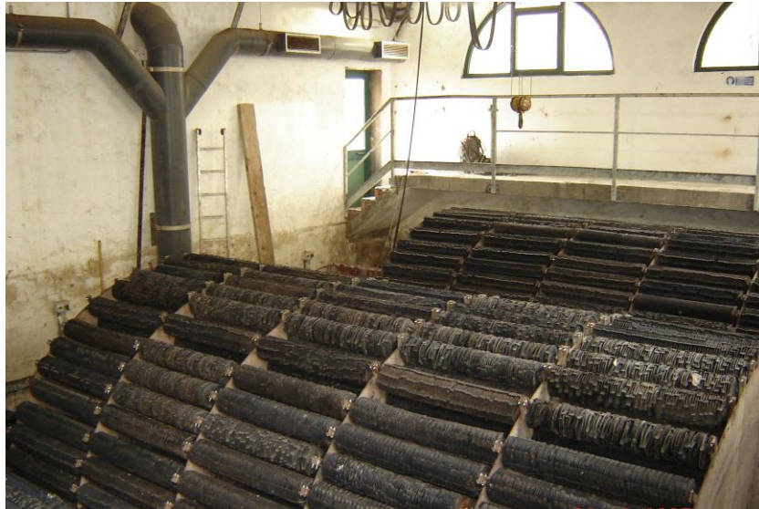
Figura 8 Biodischi Ecoplast
