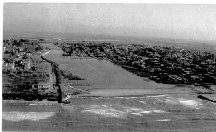
Figura 3: Vista aerea dello scolmatore Lavapiatti
