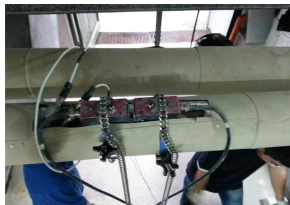
*Figura 8: Misurazione di portata del circuito solare*
