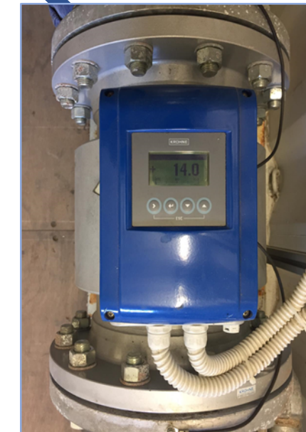
Misuratore elettromagnetico di portata
