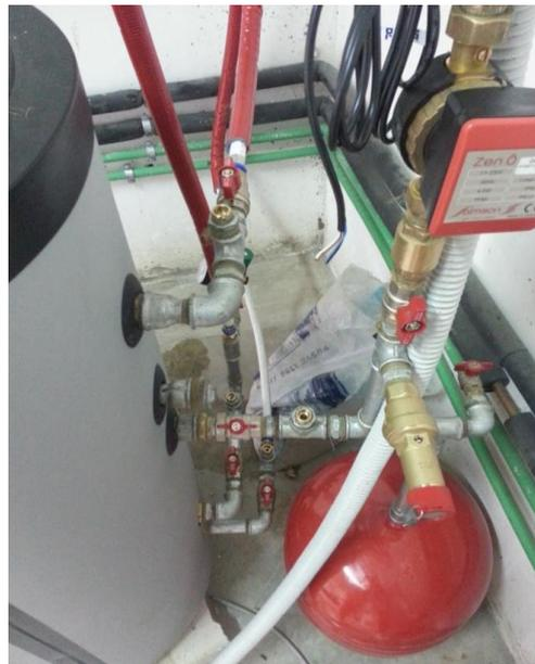
**Fig 7 Collegamento delle tubazioni al serbatoio ed installazione di valvole e pompa di circolazione**
