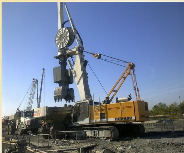
**Messa in posto con Cassoni:** sono contenitori in acciaio, di grosso diametro, utilizzabili nel caso di configurazione "funnel and gate".
