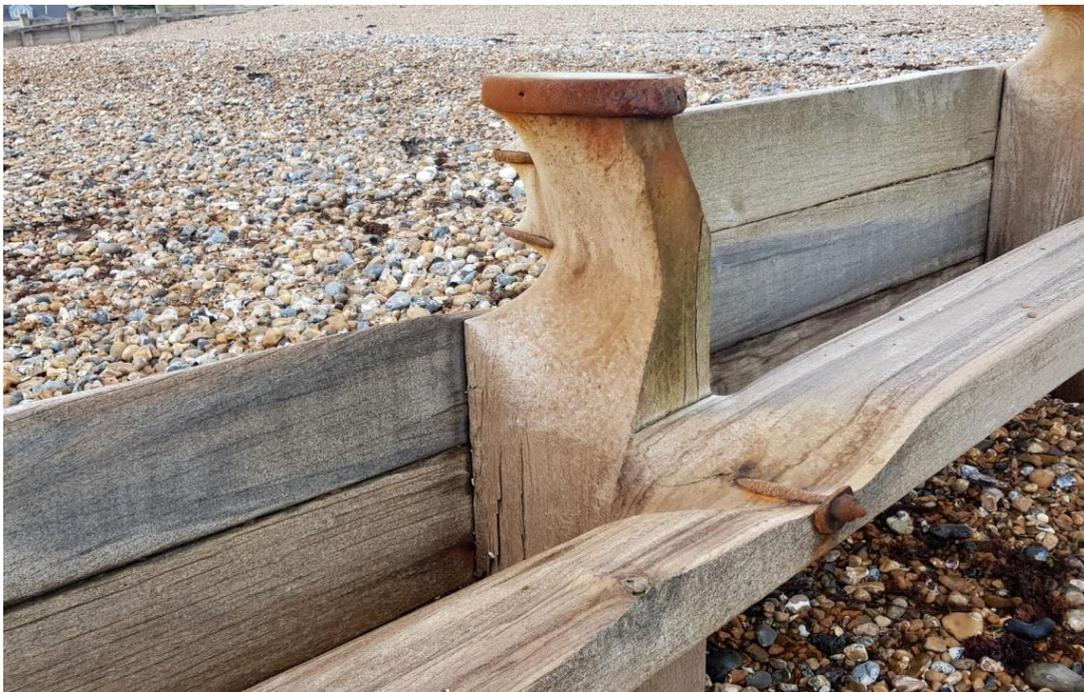
**Figura 5.** *Abrasione del palo principale*
