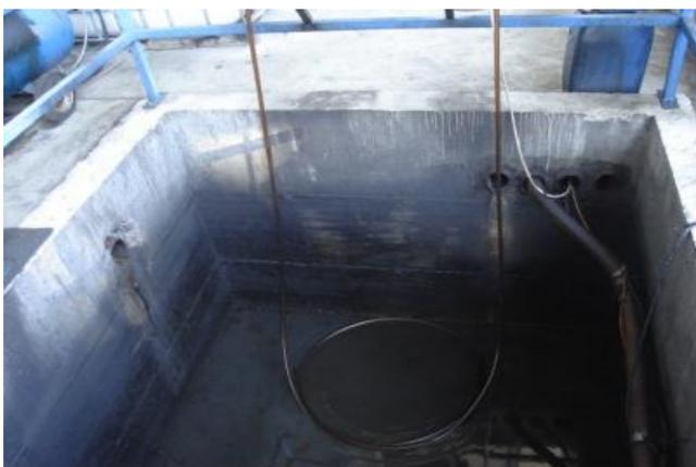
❖ L'impianto è costituito da una vasca trattamento acqua di raffreddamento di 200 m<sup>3</sup>, sulla cui superficie viene fatto ruotare un tubo galleggiante senza fine a cui aderisce l'olio;
