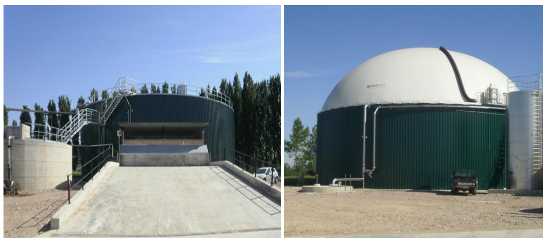
Figura 1: Digestore e Post-digestore Impianto a biogas Azienda Agricola Salera (CR)
