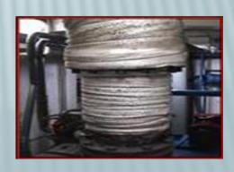
Isolamento termico di una tubazione con corde
